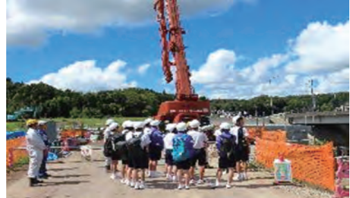
[一宮川河川工事現場の見学]
